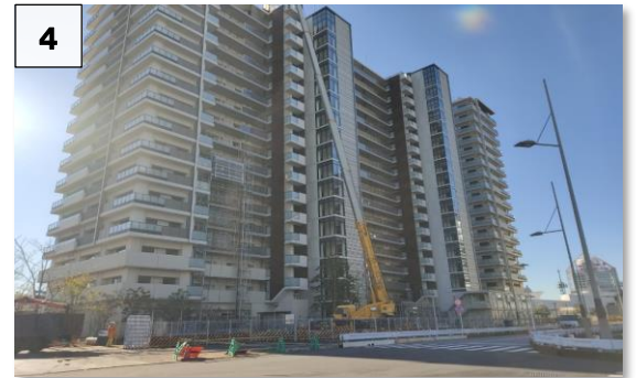
4 5-4街区 内装工事中（工事用EV組立状況）
