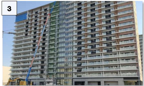
3 5-3街区 内装工事中（工事用EV組立状況）
