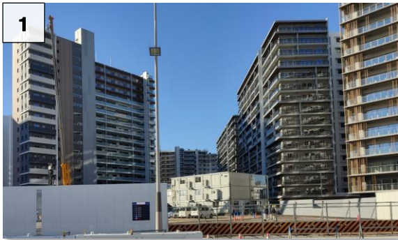
1 5-5街区 現場事務所設置状況
