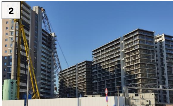
2 5-6街区 住宅棟（タワー）の準備工事状況
